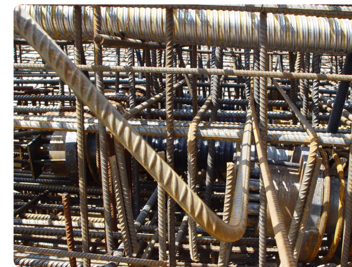
Bild 7: Viele Positionen, eventuell jede mit einer geringen Stückzahl, in einem vorgespannten Plattengeflecht
